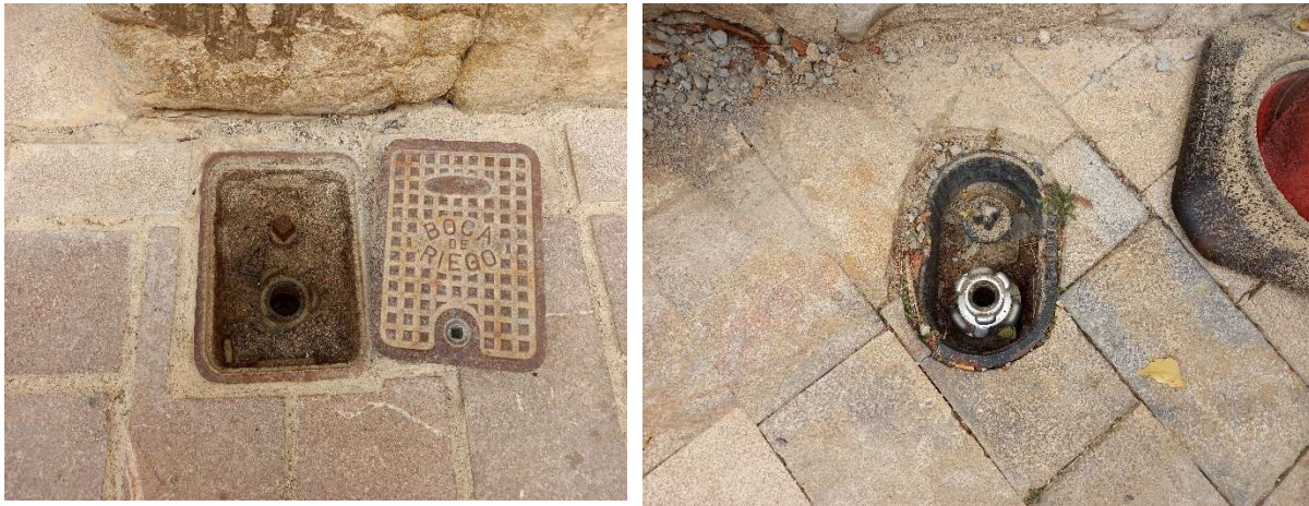
Foto 10 Hidrantes para uso terrestre dentro del casco urbano de La Mata. Fuente: Elaboración propia.
